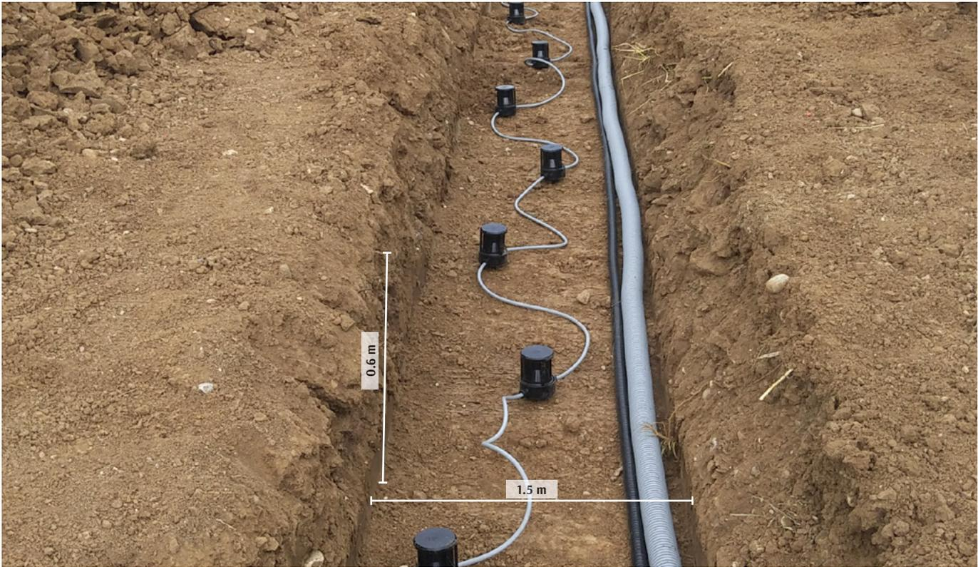
TYPICAL CONFIGURATION OF A SISMA CP 50 FIELD CABINET (2 ZONES)
